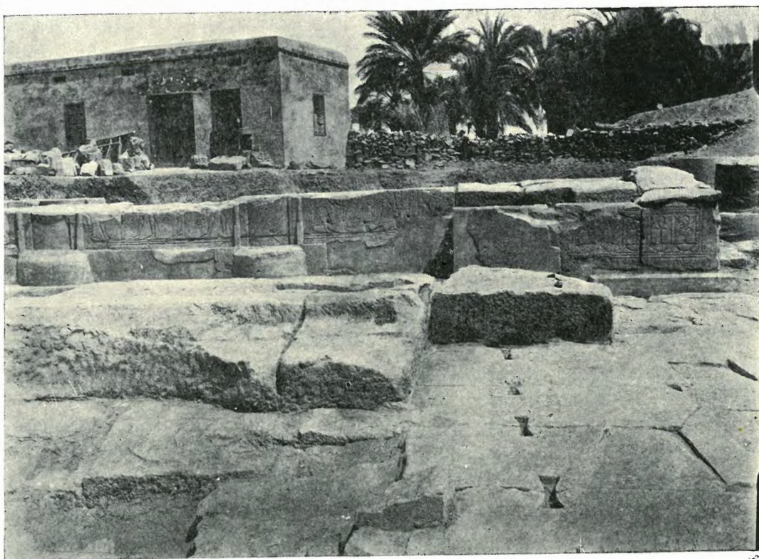
Fig. 19. — LE MONTANT NORD DE LA PORTE MÉDIANE DU MUR-PYLÔNE ET LA FACE SUD D'UNE PARTIE DU MUR NORD DU KIOSQUE NORD RÉPARÉS.
